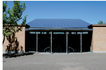
Fotovoltaikanlage auf dem KSZ Pratteln
