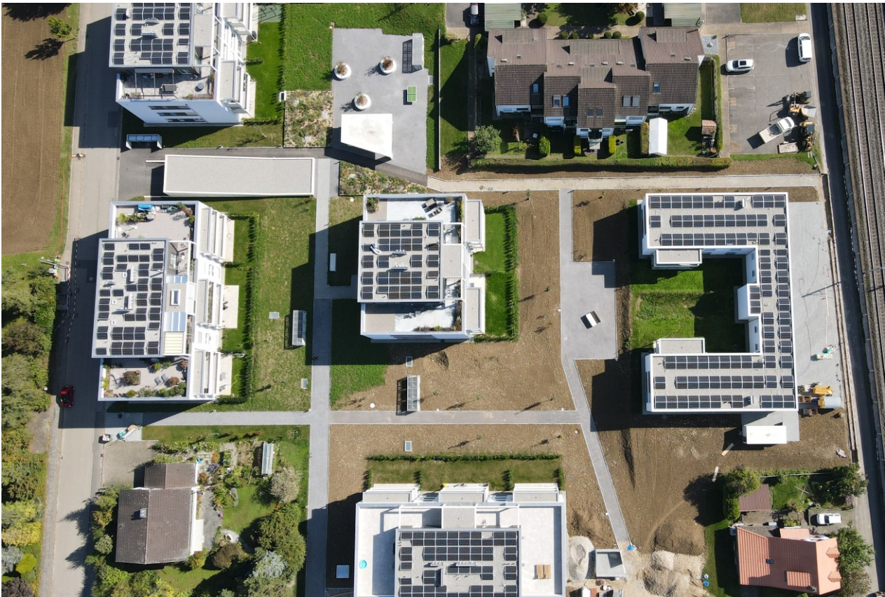
ZEV bestehend aus 5 Mehrfamilienhäusern in Ittingen, Baselland ©Solarspar, Sissach
